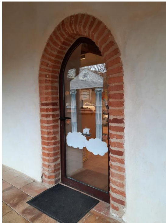
Figure 33 : Porte vitrée avec cadre métallique donnant sur la galerie à l'étage (© CREBA)
