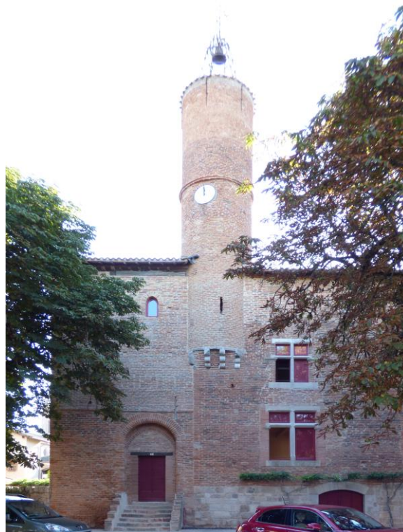
Figure 10 : L'entrée depuis la place après travaux : l'ouverture dans l'épaisseur de l'arc participe au dispositif de l'assommoir commandé depuis l'étage (voir fig. 12). La façade est dominée par l'échauguette du XIIIe siècle surélevée au XVIIe siècle et couronnée d'un campanile.
