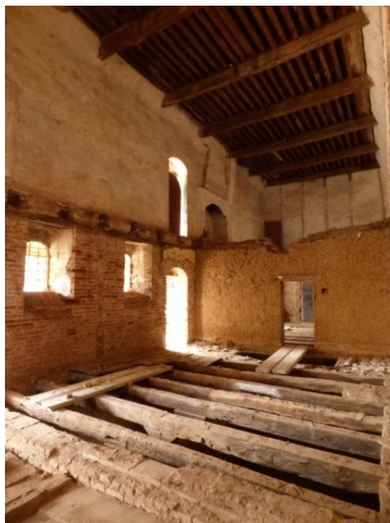
Figure 27 : Vue sur le rez-de-chaussée et le premier étage après dépose du plancher intermédiaire
