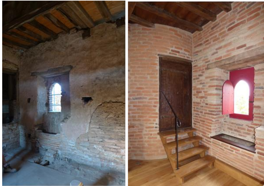
Figure 12 : Salle de l'assommoir avant et après restauration
