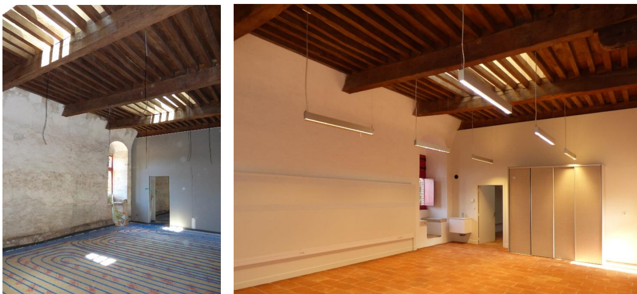
Figure 29 : Vue sur le premier niveau de l'aile ouest avant et après réhabilitation
