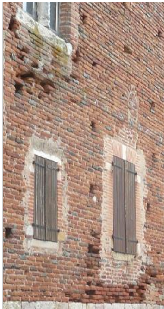
Figure 3 : Façade ouest avant travaux : briques pulvérulentes et dégradation des maçonneries.
