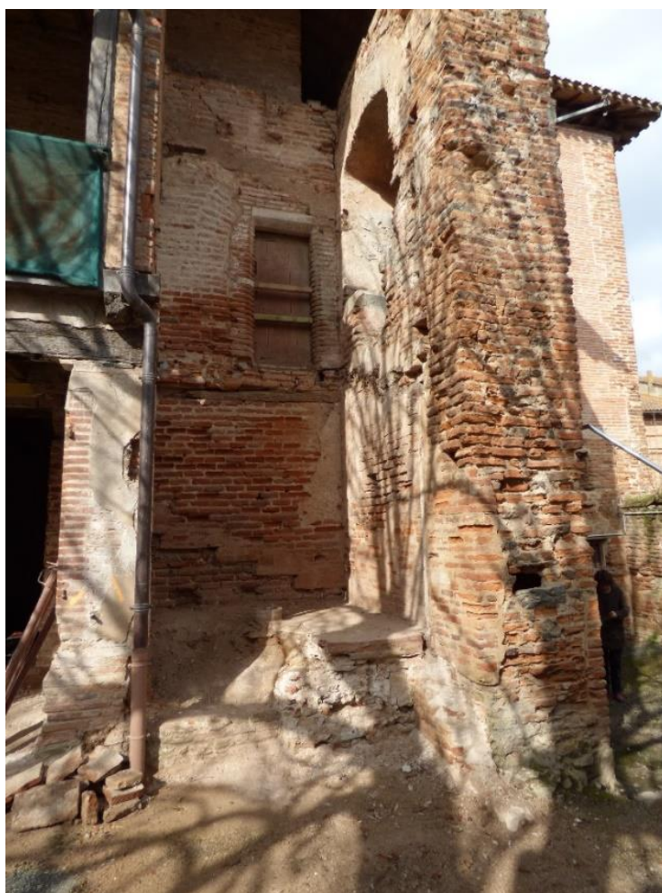
Figure 19 : Vue sur les maçonneries de la cage du grand escalier après dépose de celui-ci
