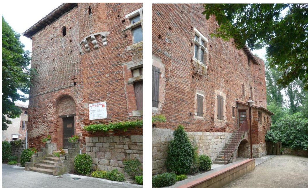
Figure 23 : Façade ouest avant restauration
