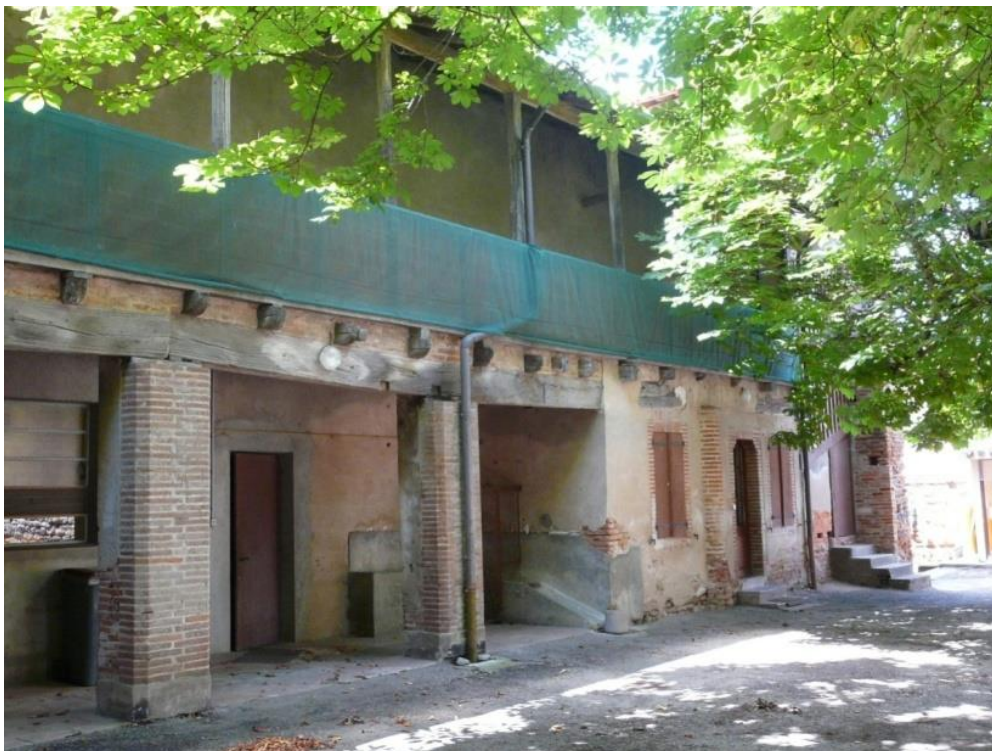
Figure 15 : Aile ouest sur cour. Structure en béton du XXe siècle sous la galerie avant démolition
