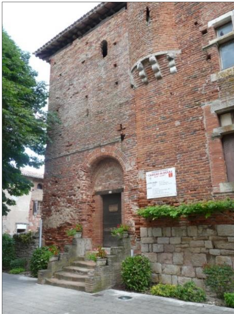
Figure 3 : Façade ouest avant travaux : briques pulvérulentes et dégradation des maçonneries.
