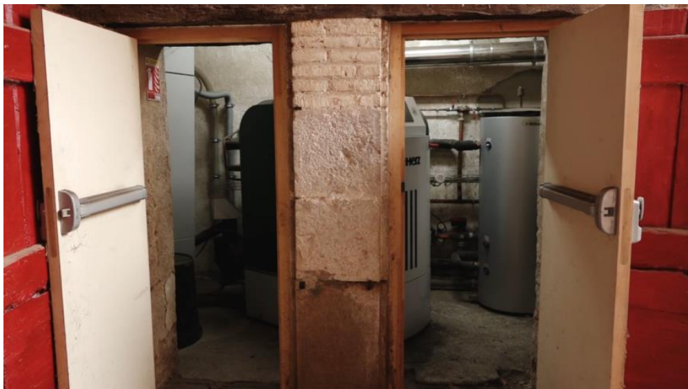
Figure 34 : Chaudière à pellets
