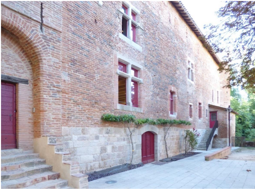
Figure 24 : Façade ouest après restauration
