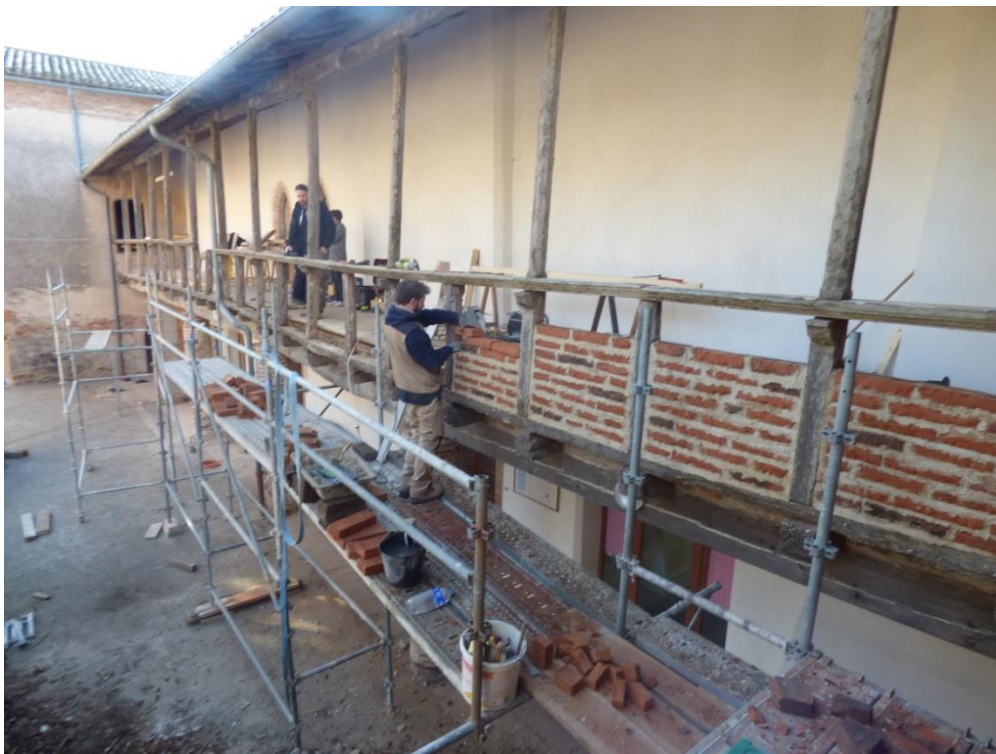
Figure 17 : Aile sud sur cour - Reprise des enduits
