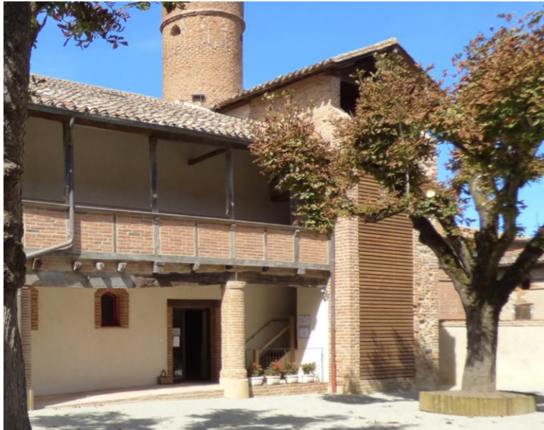
Figure 16 : Aile ouest sur cour - Après destruction de structure en béton, installation de la rampe accès PMR, modification des ouvertures de la façade au rez-de-chaussée et restauration du pilier de soutènement
