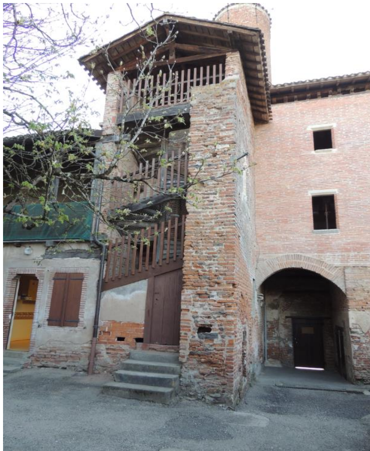
Figure 6 : Vue de l'escalier avant les travaux
