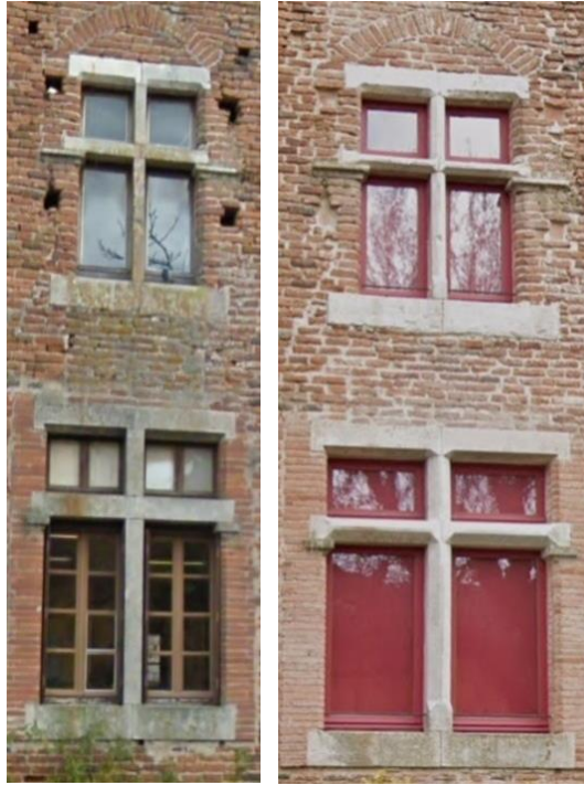
Figure 32 : Baies de la façade ouest avant et après restauration
