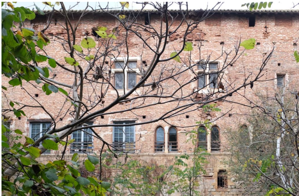
Figure 9: La façade sud sur l'Aveyron avec les baies géminées du XIIIe siècle et les croisées du XIVe siècle. En partie haute, traces de crénelage. (© Augustin Gisclard)
