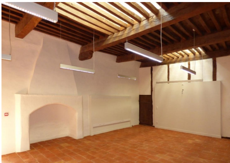
Figure 26 : Vue sur les poutres du plancher à la française et sur les deux puits de lumière depuis le premier étage
