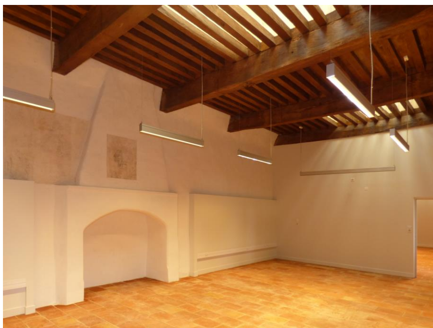
Figure 38 : une cheminée et des traces d'enduits anciens conservés dans une salle de classe de l'étage de l'aile ouest
