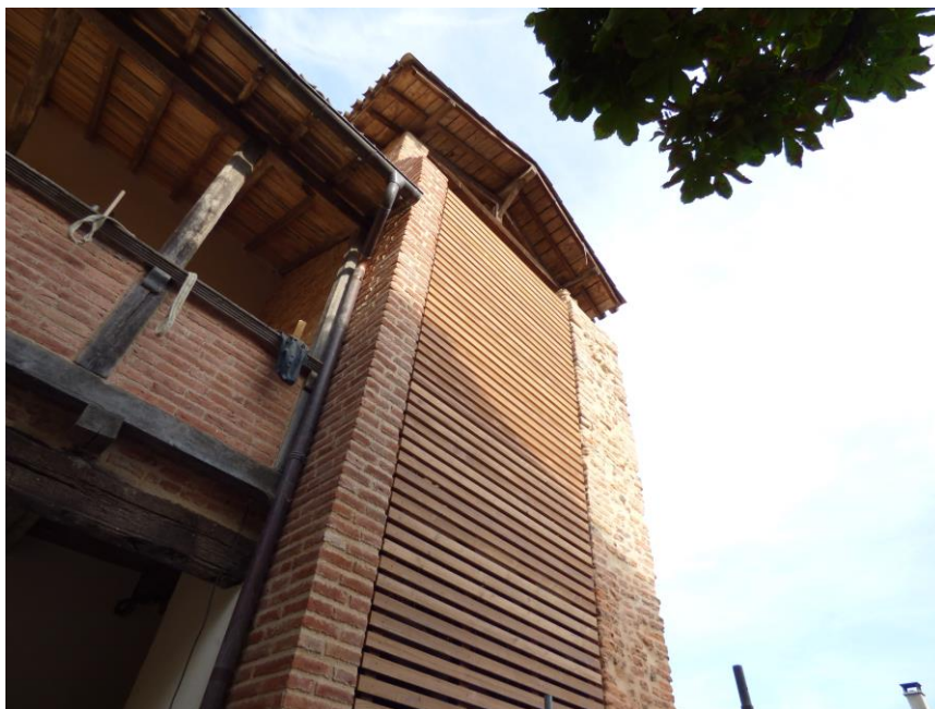
Figure 22 : Grand escalier vu depuis la cour après création du pilier gauche et du bardage en chêne chaulé
