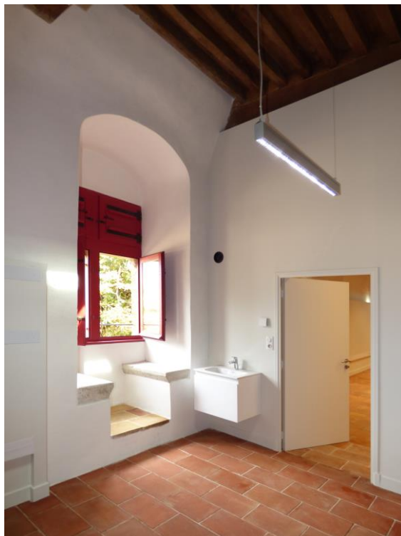
Figure 37 : Une baie à coussiège dans la salle de classe de l'étage de l'aile ouest
