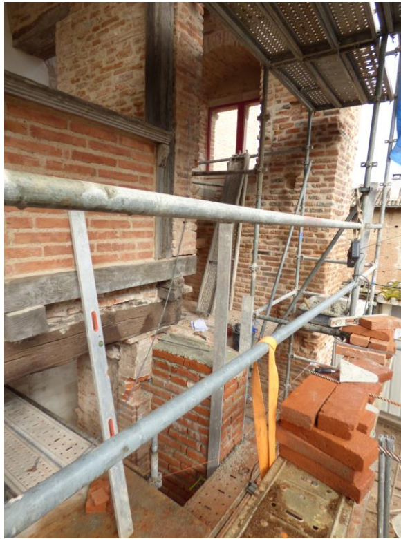
Figure 20 : Création de l'avancée du pilier gauche en briques foraines
