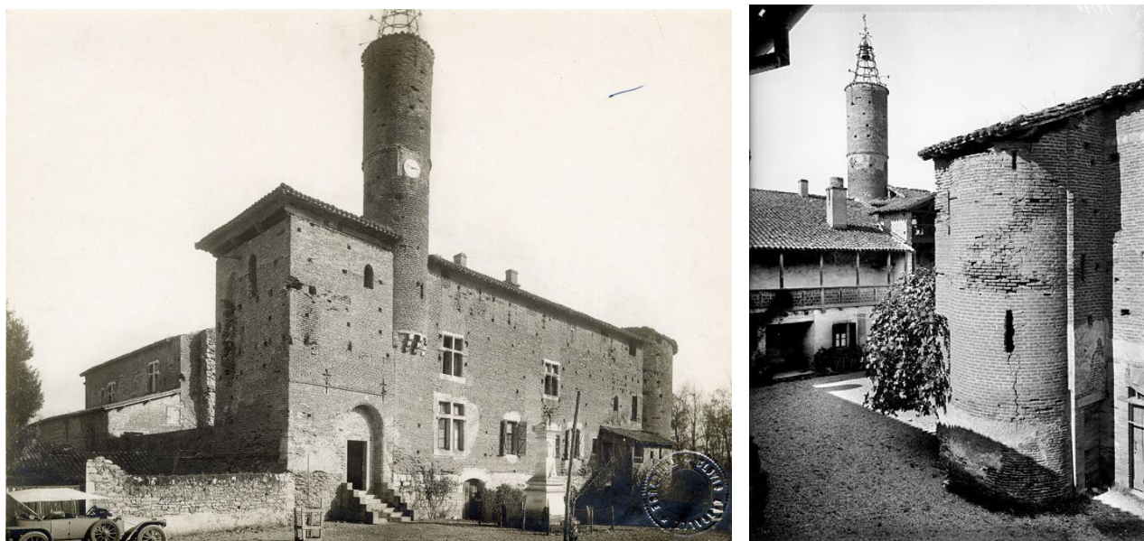
Figure 8 : Aile ouest : l'entrée du château sur la place (1957), la galerie sur cour de l'aile ouest (1927) (© Ministère de la Culture – Médiathèque du patrimoine)
