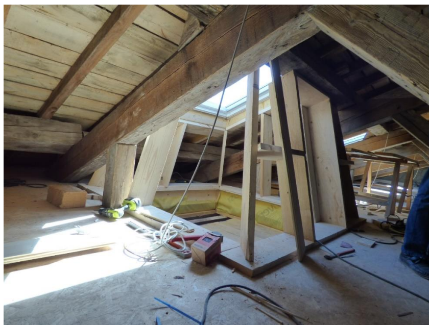
Figure 30 : Installation des verrières au niveau des combles versant est de l'aile ouest.
