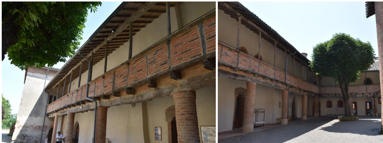
Figure 18 : Galerie de l'aile sud côté cour après restauration
