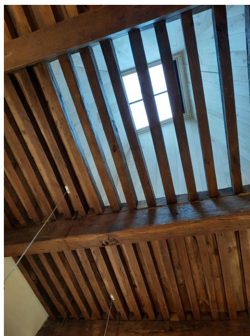
Figure 31 : Vue de la verrière à travers les solives du plancher haut. (© CREBA)
