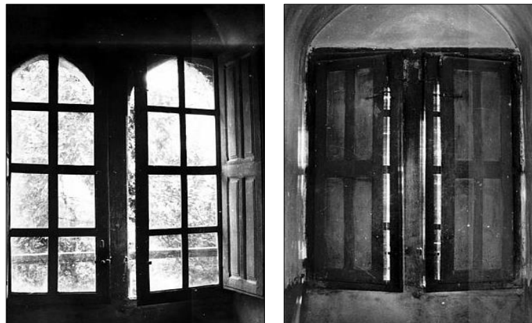
Figure 13 : Menuiseries et volets intérieurs de l'aile sud - XVIIe siècle (© Ministère de la Culture – Médiathèque du patrimoine)
