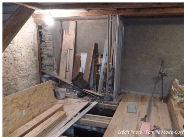
SALON PENDANT RÉNOVATION - AVEC MUR DU REMPART ISOLÉ EN BÉTON DE CHANVRE PROJETÉ.
