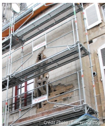
MISE À NU DE LA FAÇADE PRINCIPALE, DÉPÔT DE L'ENDUIT AU CIMENT ET DU SUPPORT D'ENDUIT
