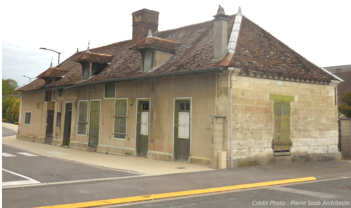
AVANT TRANSFORMATION ET RÉNOVATION
