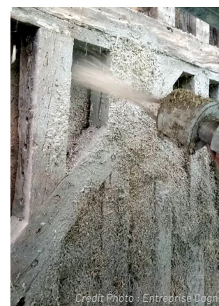
PROJECTION ENTRE PANS DE BOIS DU BÉTON DE CHANVRE PAR L'EXTÉRIEUR
