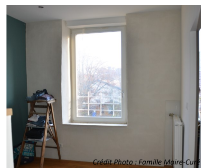
FINITION - ENDUIT DE CORPS CHAUX-ARGILE + ENDUIT DE FINITION À LA CHAUX
