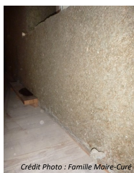
DOUBLAGE INTÉRIEUR EN BÉTON DE CHANVRE PROJETÉ SUR 10 CM D'ÉPAISSEUR
