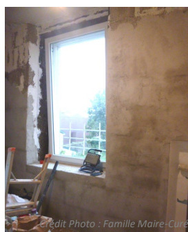
DOUBLAGE - POSE DES BLOCS DE CHANVRE AU 2ÈME ÉTAGE
