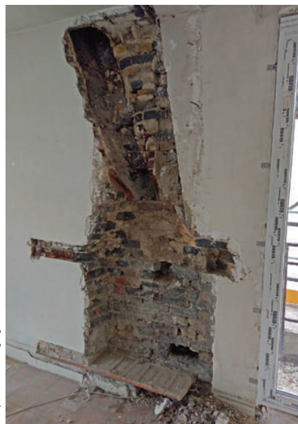
Destruction d'une cheminée et de son conduit à la demande d'un locataire (« gain de place »). Cette intervention est contraire aux attentes du PLU de Paris comme formulées à l'article 15. Groupe Fécamp (Paris 12 e ) – Paris-Habitat.
