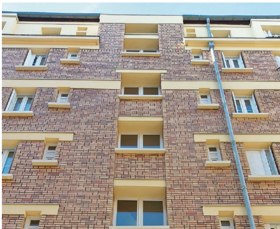
ITE reproduisant l'aspect briques apparentes des HBM Groupe Aristide Briand (Gentilly) – Novigere
