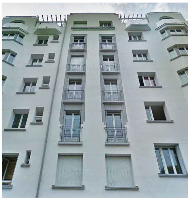
HBM isolée par l'extérieur par un ETICS (« systèmes composites d'isolation extérieure »), généralement appelé « enduit sur isolant ». Groupe Clovis (Paris 5e) – Paris Habitat
