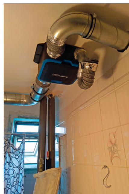
Chantier d'installation d'une VMC centralisée à l'échelle du logement. Groupe Fécamp (Paris 12 e ) – Paris-Habitat
