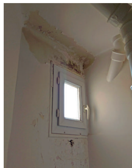
Moisissures et décollement de peinture Avec le double vitrage, la condensation se fixe essentiellement sur le pont thermique du plancher Haut. Groupe Gambetta (Paris 20 e ) – Elogie-SIEMP
