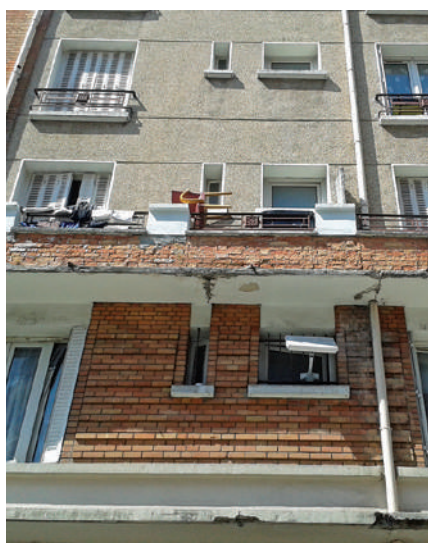
L'action érosive de l'eau : décollement de l'enduit ciment des briques creuses composant l'allège des balcons. Action corrosive de l'eau : éclatement des fers en sous face des balcons. Groupe Serpollet (Paris 20 e ) – Paris Habitat
