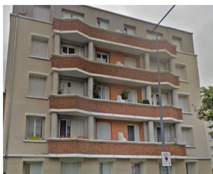
Façade isolée par l'extérieur , les seules briques encore visibles sont celles des balcons qui n'ont pas été recouvertes d'isolant. Groupe des Vergers du Fort (Nogent-sur-Marne) – Valophis
