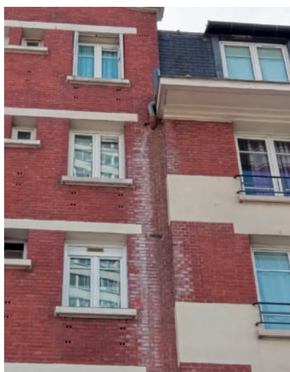
Efflorescences de sels contenus dans les briques consécutifs à la fuite de la canalisation d'eau pluviale. Groupe de la Porte d'Ivry (Paris 13 e ) – Paris Habitat
