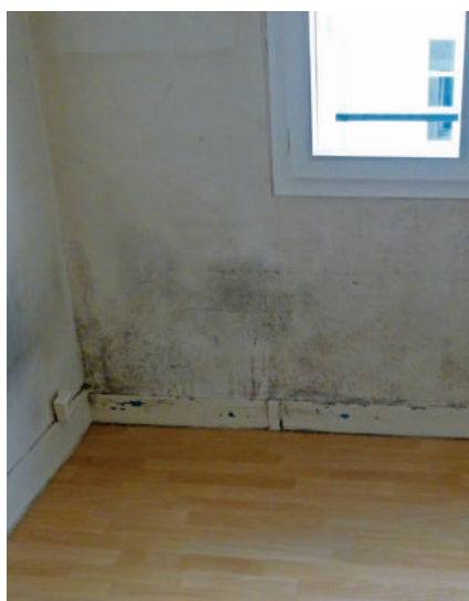
Développement de moisissures d'une chambre d'HBM avant chantier de réhabilitation. Groupe Pierre Nicole (Paris 5 e ) – Elogie-SIEMP
