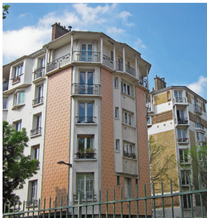
Revêtement de type Glasal mis en œuvre sur certaines façades enduites lors d'une opération Palulos. Le rôle d'isolation de ce type de revêtement est faible voire nul. Ce bardage a été retiré récemment lors d'un ravalement. Groupe de la Porte de Clignancourt (Paris 18e) – Paris Habitat
