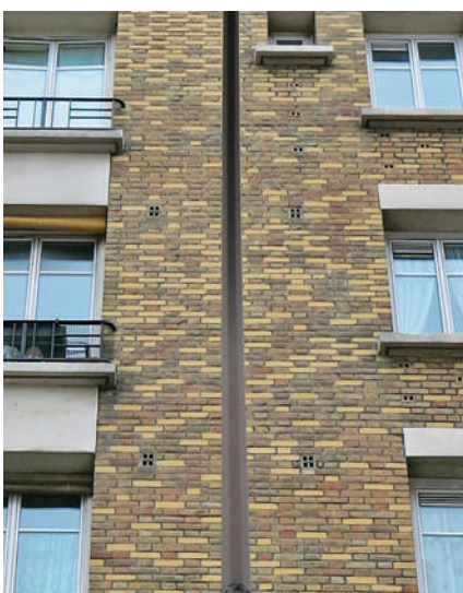
Peinture de protection appliquée sur certaines briques (elles apparaissent en clair) Groupe Sérurier (Paris 19 e ) – Paris Habitat
