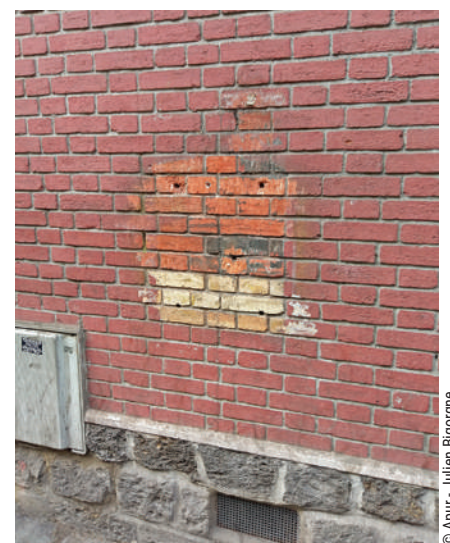
Au centre apparaît la couleur d'origine des briques (ocre et beige). Le reste de la façade a été peint en rouge et hydrofugé. Groupe Ourcq (Paris 19 e ) – Paris Habitat
