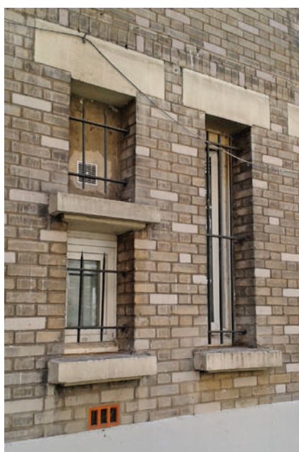
En haut à gauche, extracteur de VMC type A installé dans une ancienne trémie de WC. Groupe Porte de Montreuil (Paris 12 e ) – Paris Habitat.
