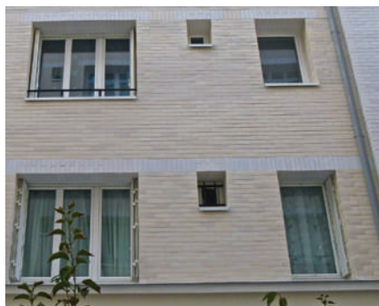
Isolation thermique extérieure mise en œuvre sur cour HBM. Le parement retenu est la brique vernissée blanche. Groupe Pierre Nicole (Paris 5e) – Elogie-SIEMP
