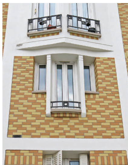
Ravalement ayant été suivi par la mise en peinture de la totalité des briques. Le choix de deux teintes fait évoluer l'aspect général de la façade en créant de nouveaux motifs, notamment des lignes diagonales, qui étaient absentes de la façade d'origine composée d'une seule teinte de brique. Groupe Sembat (Paris 18 e ) – Paris Habitat
