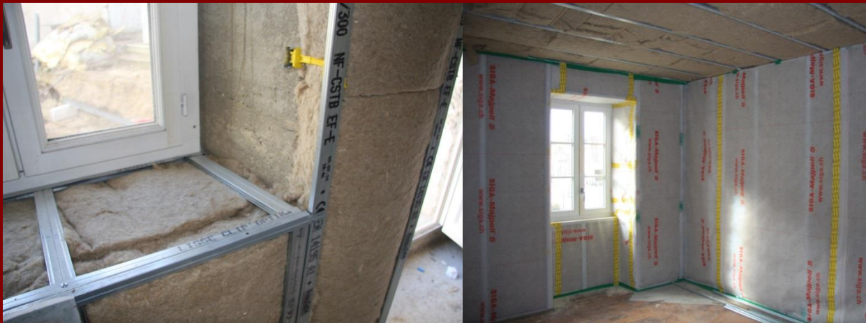
Intérieur : isolation plaquée : isolant biosourcé + film hygrovariable + fermacell
