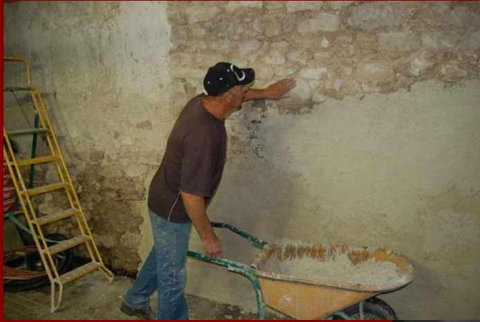
Intérieur : enduits chaux-chanvre en amélioration thermique
